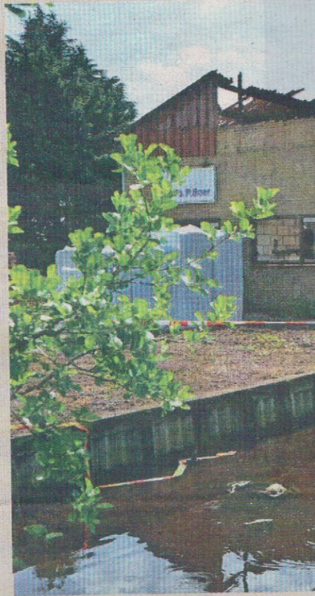
▲ Voor de asbestschoonmaak wordt d
